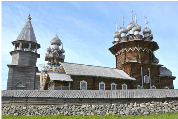
L'église en bois en cours de restauration
